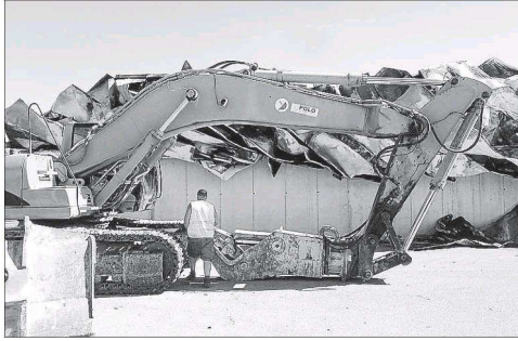
La máquina, lista para comenzar a retirar parte de los escombros.
