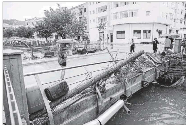
Las vallas de uno de los puentes quedó destrizada por la fuerza del agua. Foto: JOSEP BAGUR
