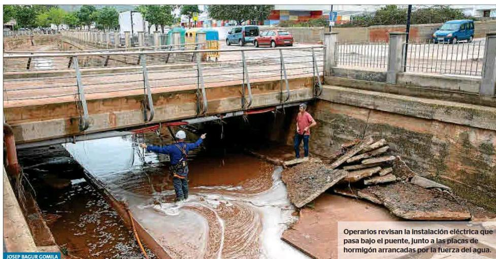
Operarios revisan la instalación eléctrica que pasa bajo el puente. Junto a las placas de hormigón arrancadas por la fuerza del agua.
