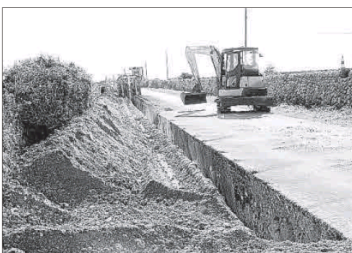
Avanzan los trabajos, en Son Salomó y en el Camí de Punta Nati, de canalización del tendido eléctrico hasta la estación de Endesa.
