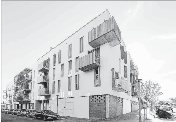
Fachada de planta baja pendiente de incluir en el proyecto. Edificio del Ibavi en Maó que albergará el equipamiento social para personas que requieran puntualmente un lugar donde asearse, descansar o pernoctar y donde encuentren también servicios de acompañamiento. Foto: KATERINA PU
