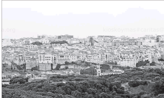
El Informe cifra el parque inmobiliario de Menorca en un total de 60.523 viviendas. Foto: GEMMA ANDREU
