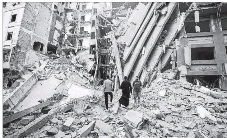
Edificio derrumbado a causa de los constantes bombardeos en la Franja de Gaza. Foto: HAITHAM IMAD/EFE
