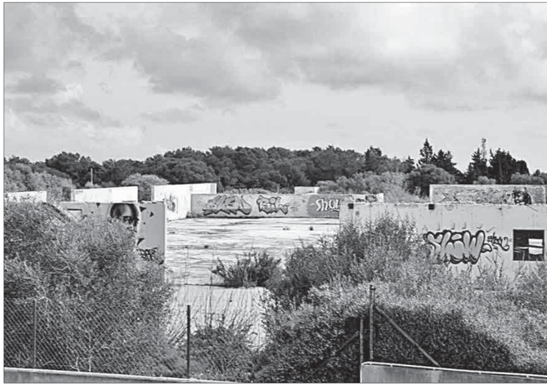
El recinto, en la zona de Torelló de Maó, donde se hallaba la planta TIV que se incendió. Foto: KATERINA PU
